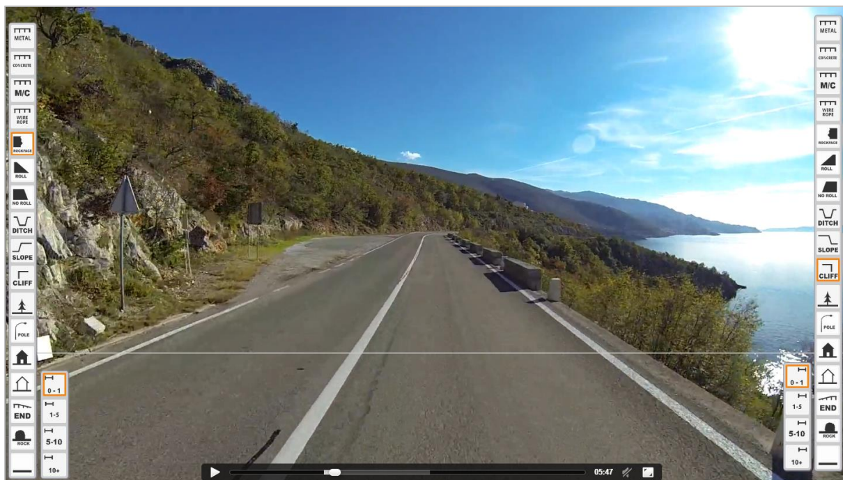
Slika 18. Primjer opasnog mjesta s provalijom na desnoj strani ceste, bez postavljene zaštitne odbojne ograde
