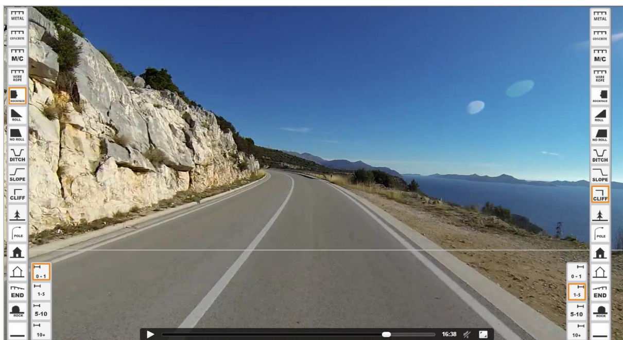
Slika 25. Primjer opasnog mjesta sa provalijom na desnoj strani ceste, bez postavljene zaštitne odbojne ograde i izbočenim stijenama s lijeve strane ceste
