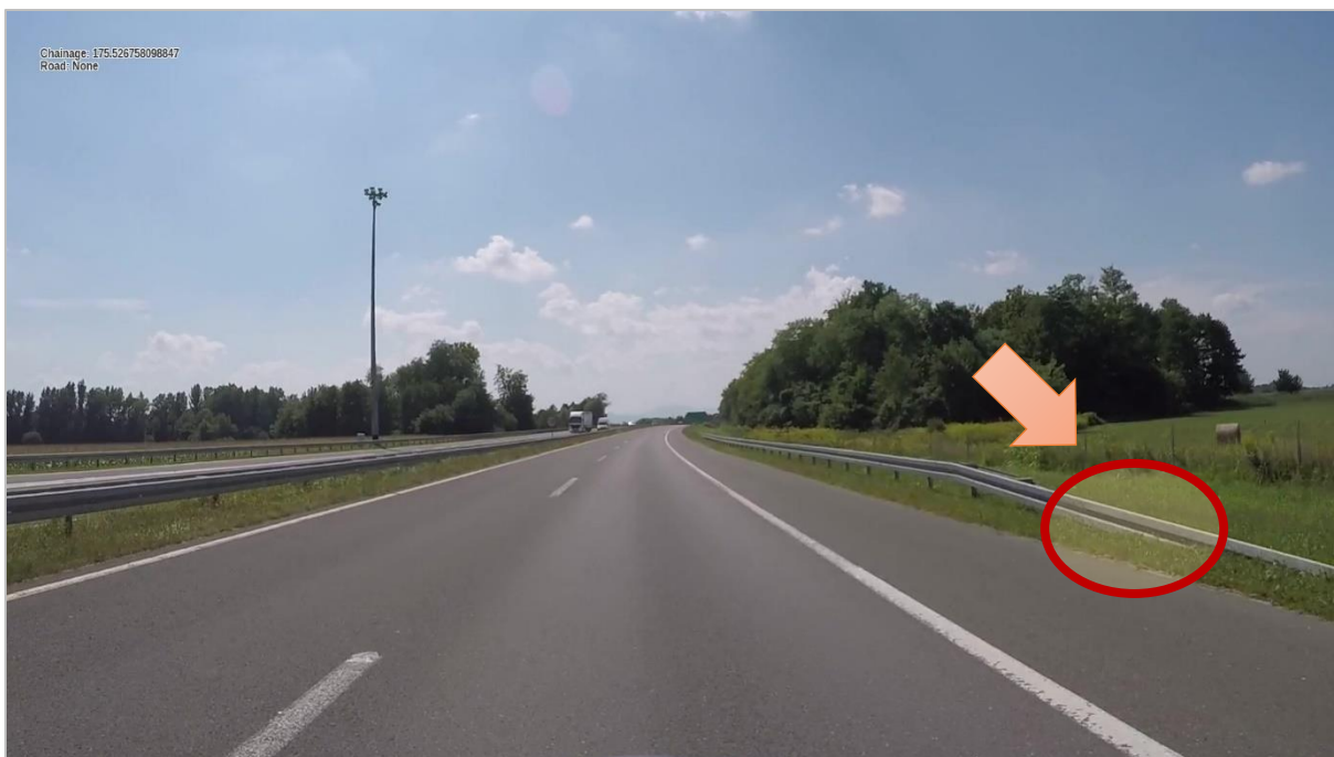
Slika 30. Primjer opasnog mjesta s nezaštićenim početkom metalne zaštitne odbojne ograde na desnoj strani ceste
