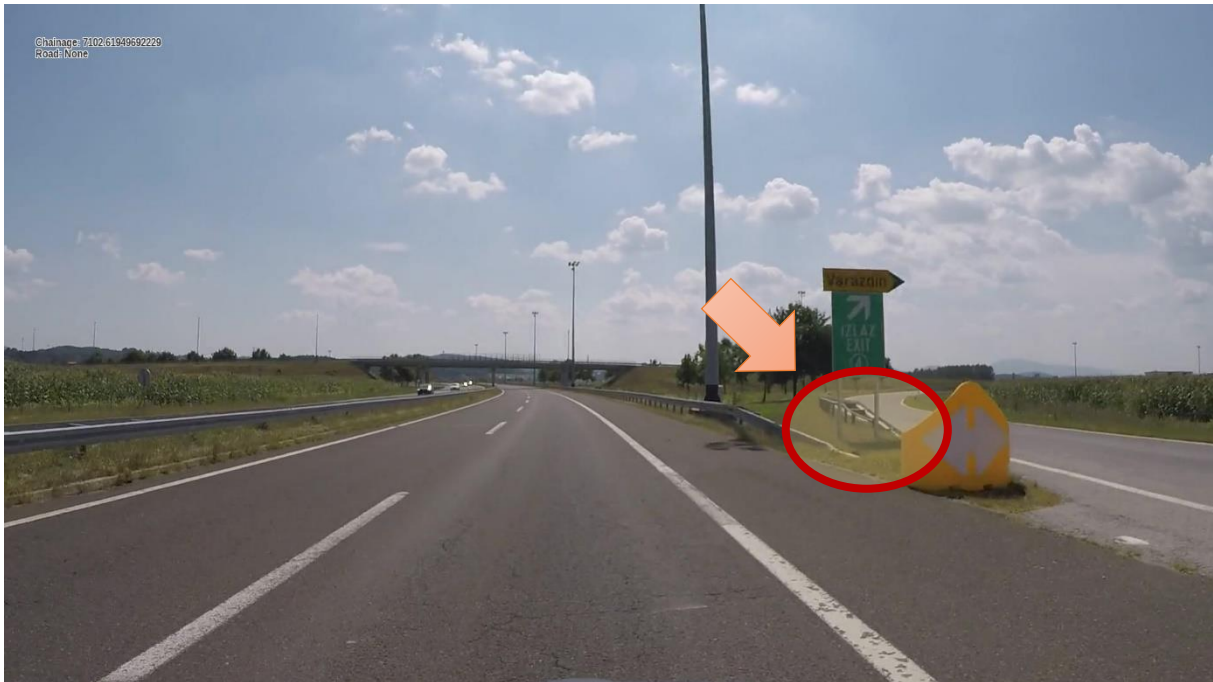
Slika 28. Primjer opasnog mjesta s nezaštićenim početkom metalnih zaštitnih odbojnih ograda na desnoj strani ceste u vrhu razdjelnog otoka traka za izlivanje prometnog toka
