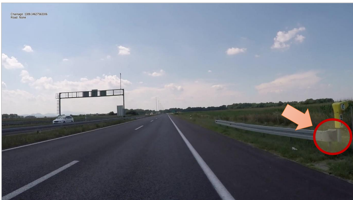
Slika 31. Primjer opasnog mjesta s prekidom u zaštitnoj odbojnoj ogradi
