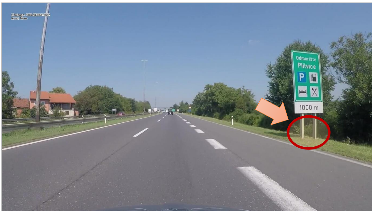
Slika 18. Primjer opasnog mjesta s nezaštićenim stupovima prometnog znaka na desnoj strani ceste, bez postavljene zaštitne odbojne ograde
