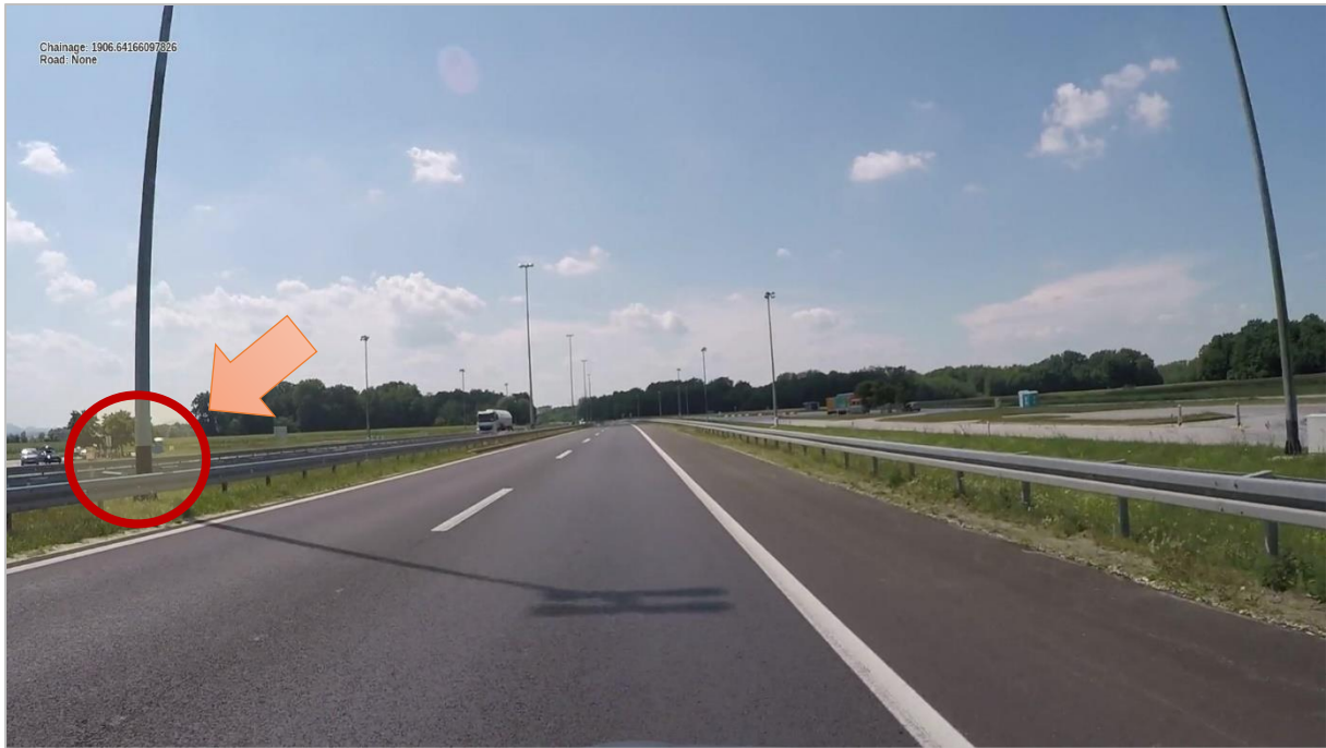
Slika 32. Primjer opasnog mjesta sa metalnom zaštitnom odbojnom ogradom postavljenom neposredno ispred stupova javne rasvjete na lijevoj strani ceste.
