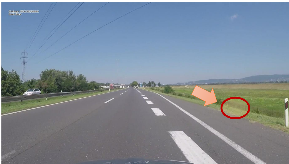
Slika 20. Primjer opasnog mjesta s nezaštićenim visokim nasipom na desnoj strani ceste
