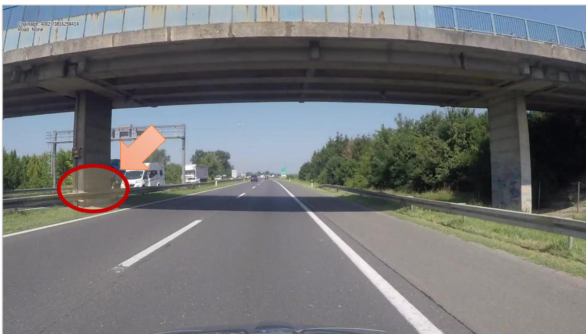
Slika 23. Primjer opasnog mjesta sa metalnom zaštitnom odbojnom ogradom postavljenom neposredno ispred stupa nadvožnjaka na lijevoj strani ceste.
