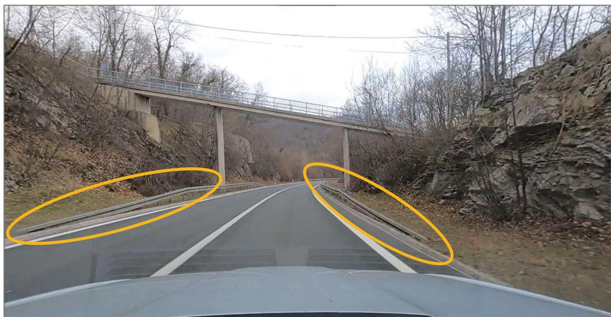
Slika 45 - Primjer opasnog mesta s nezaštićenim početkom metalne zaštitne odbojne ograde
