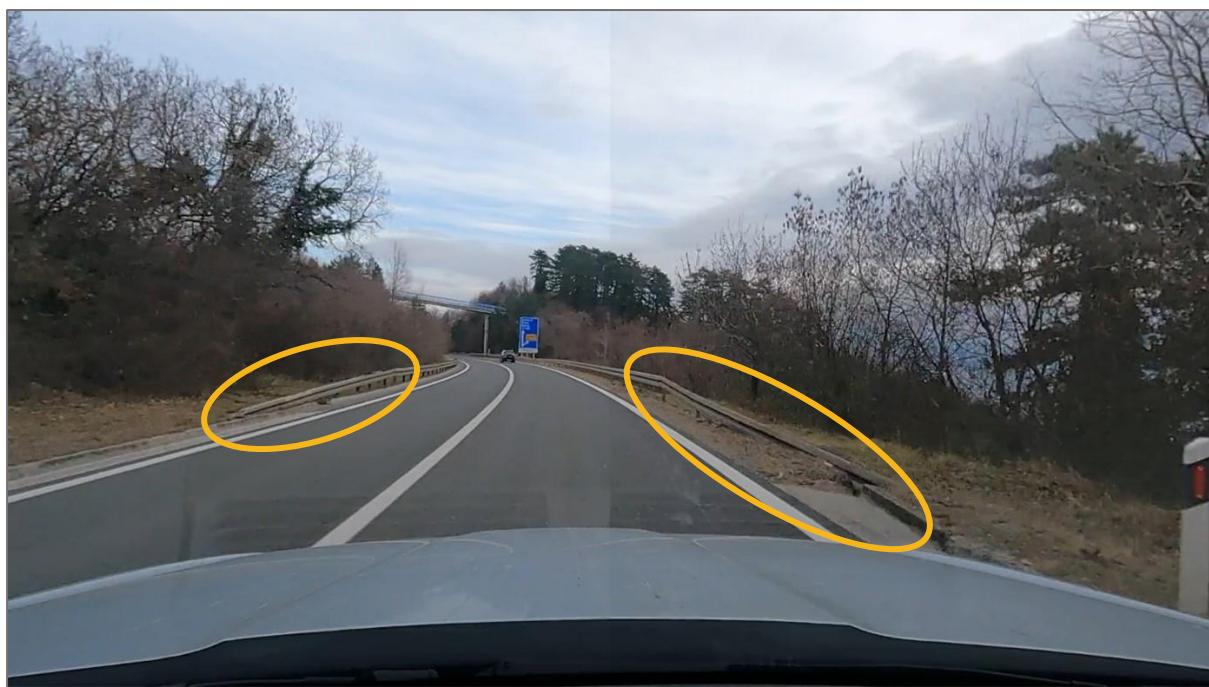
Slika 37 - Primjer opasnog mesta s nezaštićenim završnim elementima metalne zaštitne odbojne ograde
