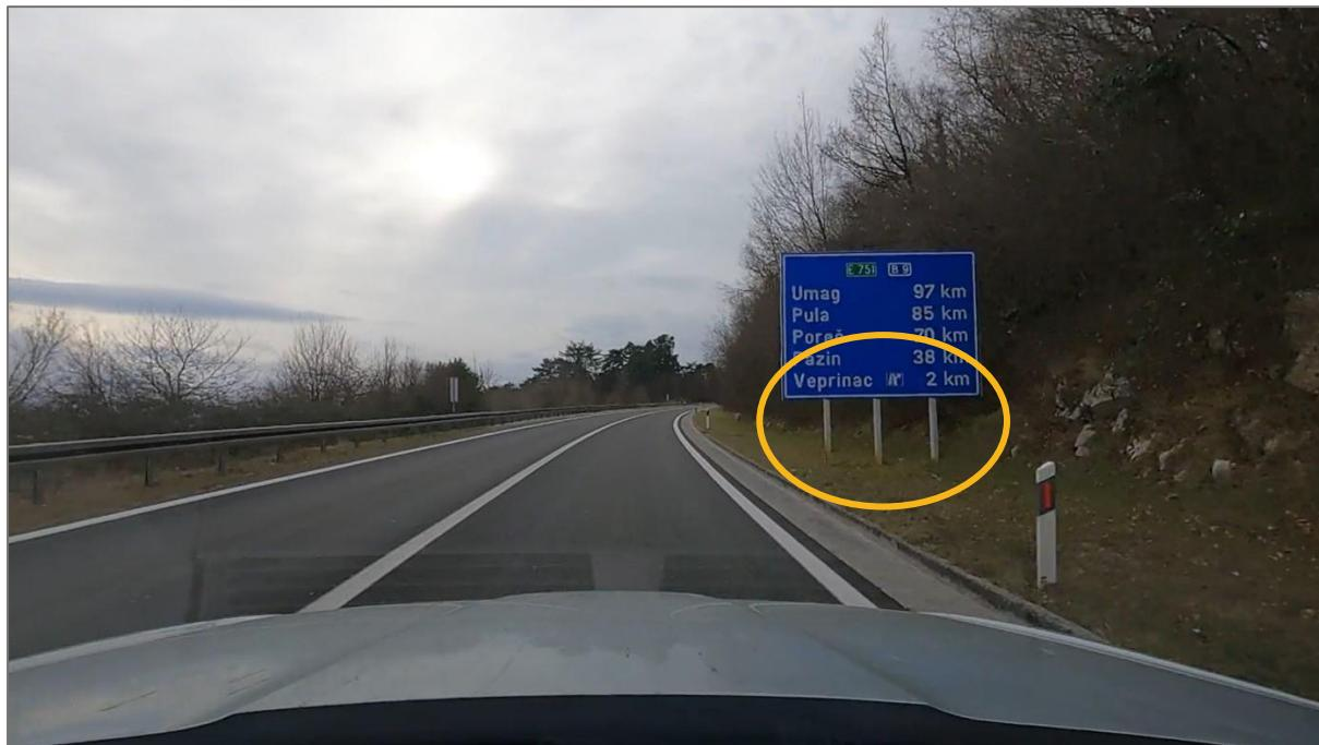
Slika 36 - Primjer opasnog mesta s nezaštićenim stupovima vertikalne prometne signalizacije, promjera većeg od 10 cm
