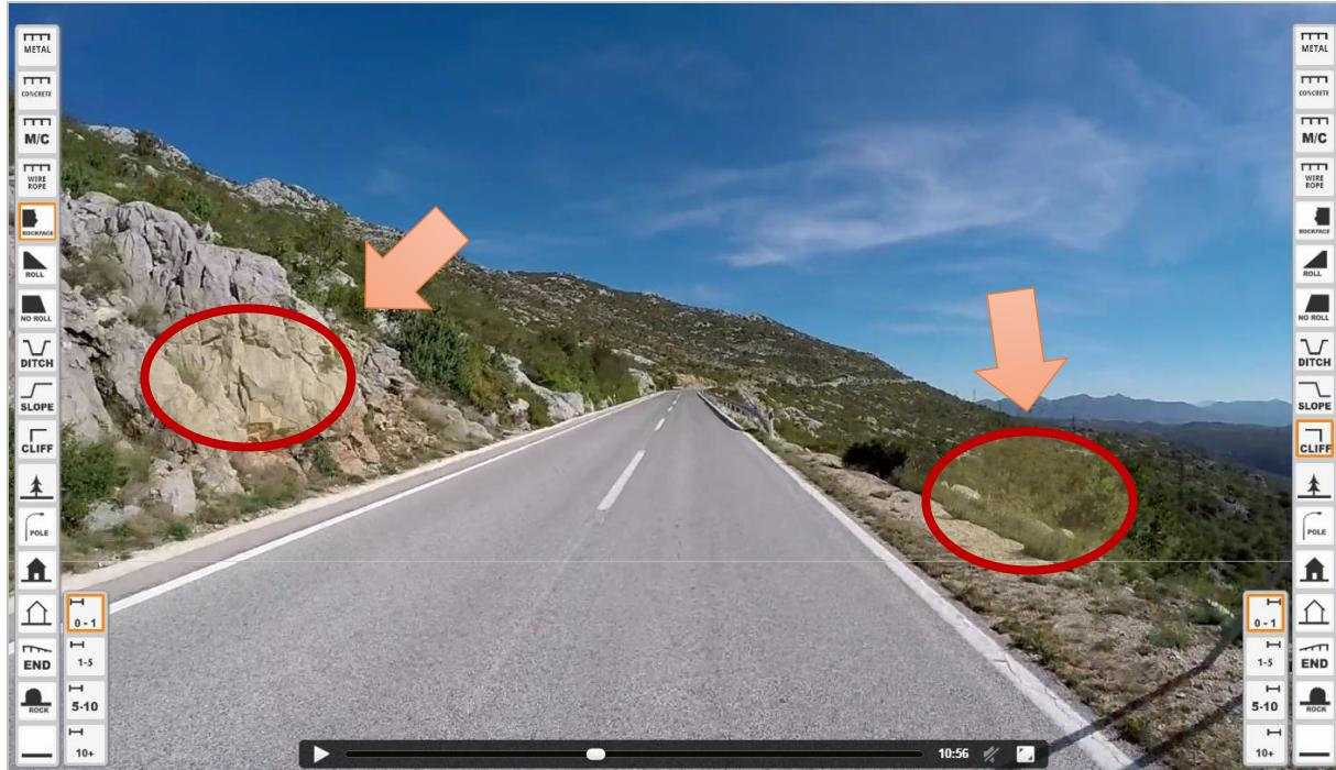
**Slika 29. Primjer opasnog mesta sa provaljom na desnoj strani ceste, bez postavljene zaštitne odbojne ograde i izbočenim stijenama s lijeve strane ceste**
