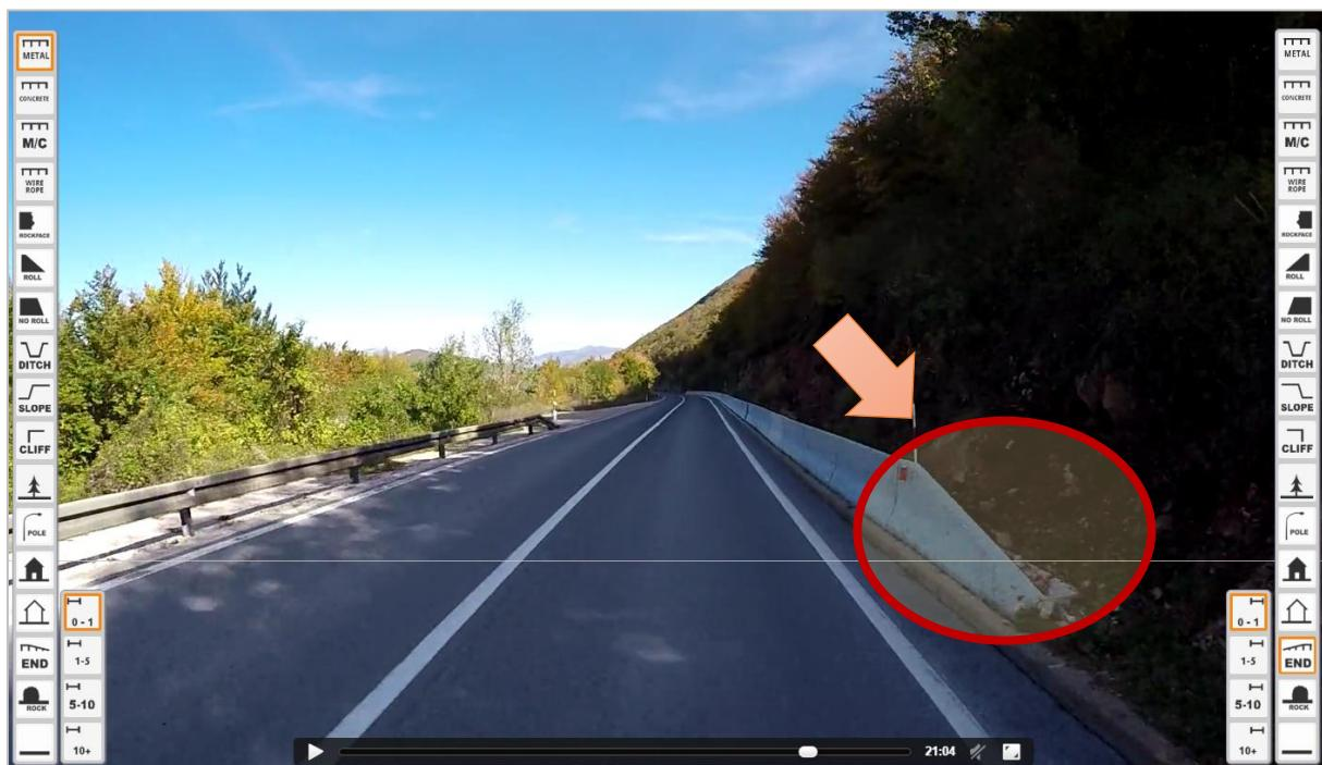
**Slika 30. Primjer opasnog mesta s nezaštićenim početkom betonske zaštitne odbojne ograde na desnoj strani ceste**
