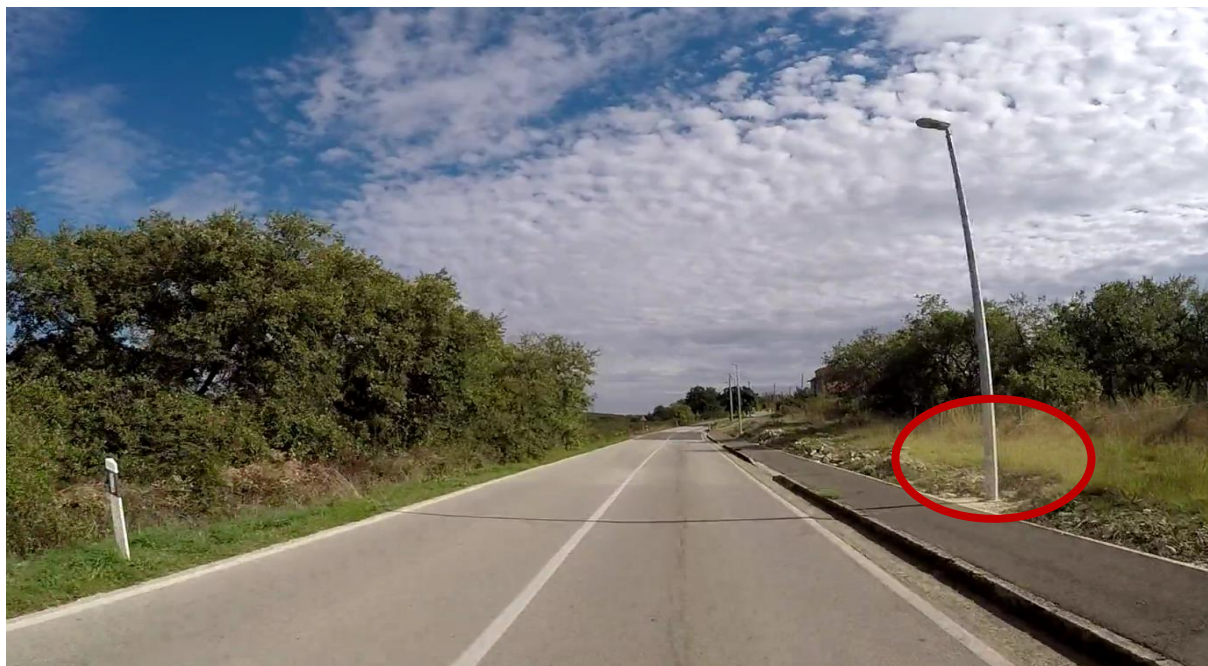
Slika 46. Primjer opasnog mjesta s nezaštićenim stupom većeg promjera na desnoj strani ceste (dionica Nin – Zemunik Donji).
