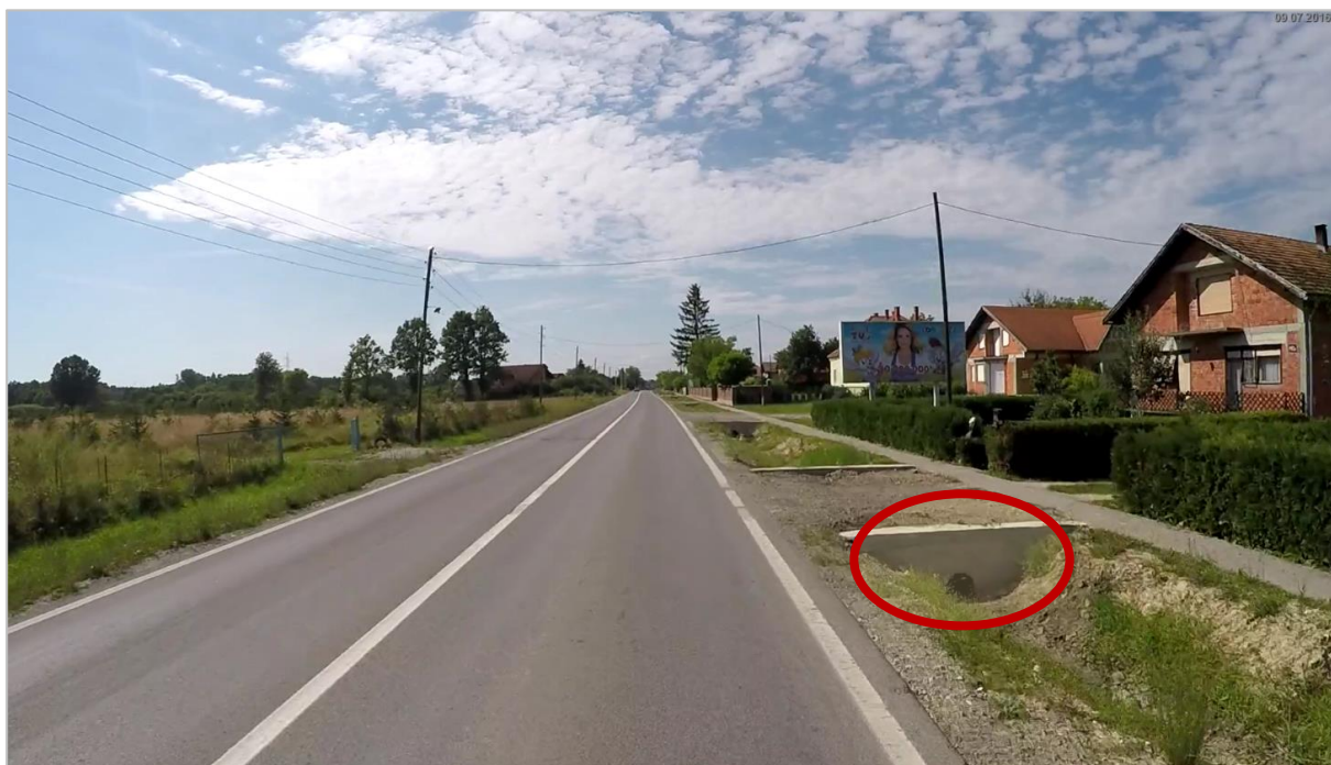
Slika 36. Primjer opasnog mjesta s dubokim odvodnim kanalom i betonskim prijelazom na desnoj strani ceste (dionica Velika Gorica – Žažina).
