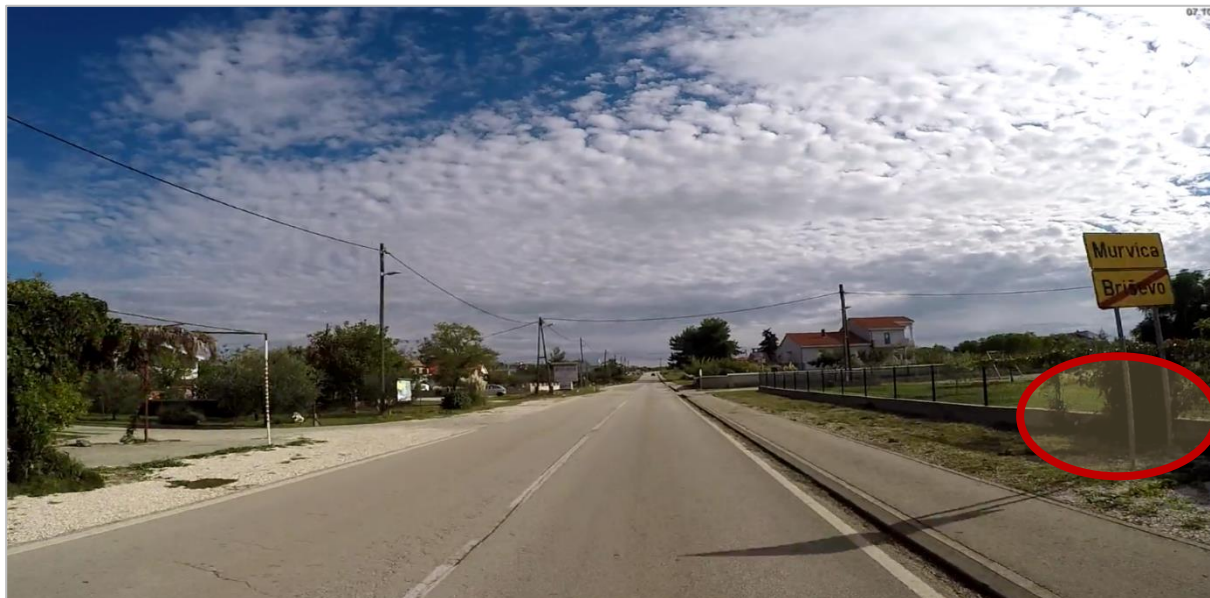
Slika 47. Primjer opasnog mjesta s nezaštićenim prometnim znakom sa stupovima većeg promjera na desnoj strani ceste (dionica Nin – Zemunik Donji).
