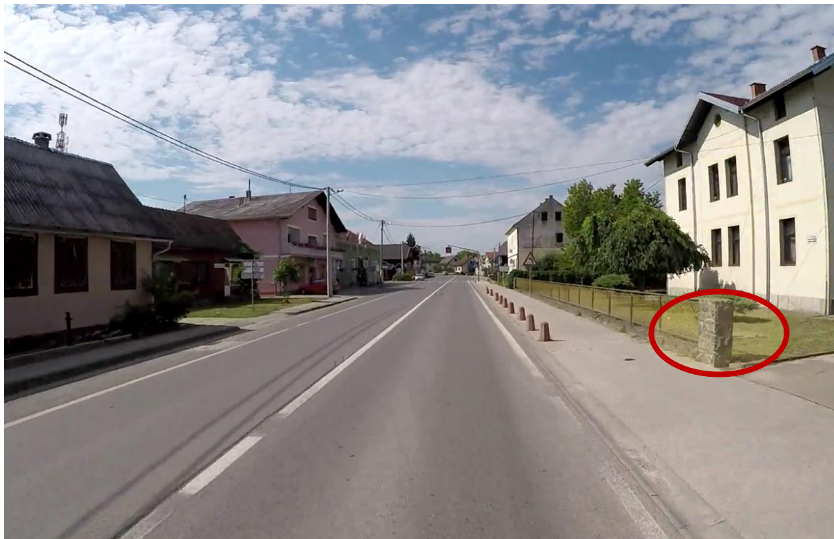
Slika 41. Primjer opasnog mjesta s opasnim čvrstim objektom na desnoj strani ceste (dionica Velika Gorica – Žažina).
