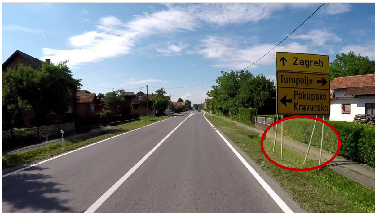
Slika 38. Primjer opasnog mjesta s nezaštićenim prometnim znakom sa stupovima većeg promjera na desnoj strani ceste (dionica Velika Gorica – Žažina).
