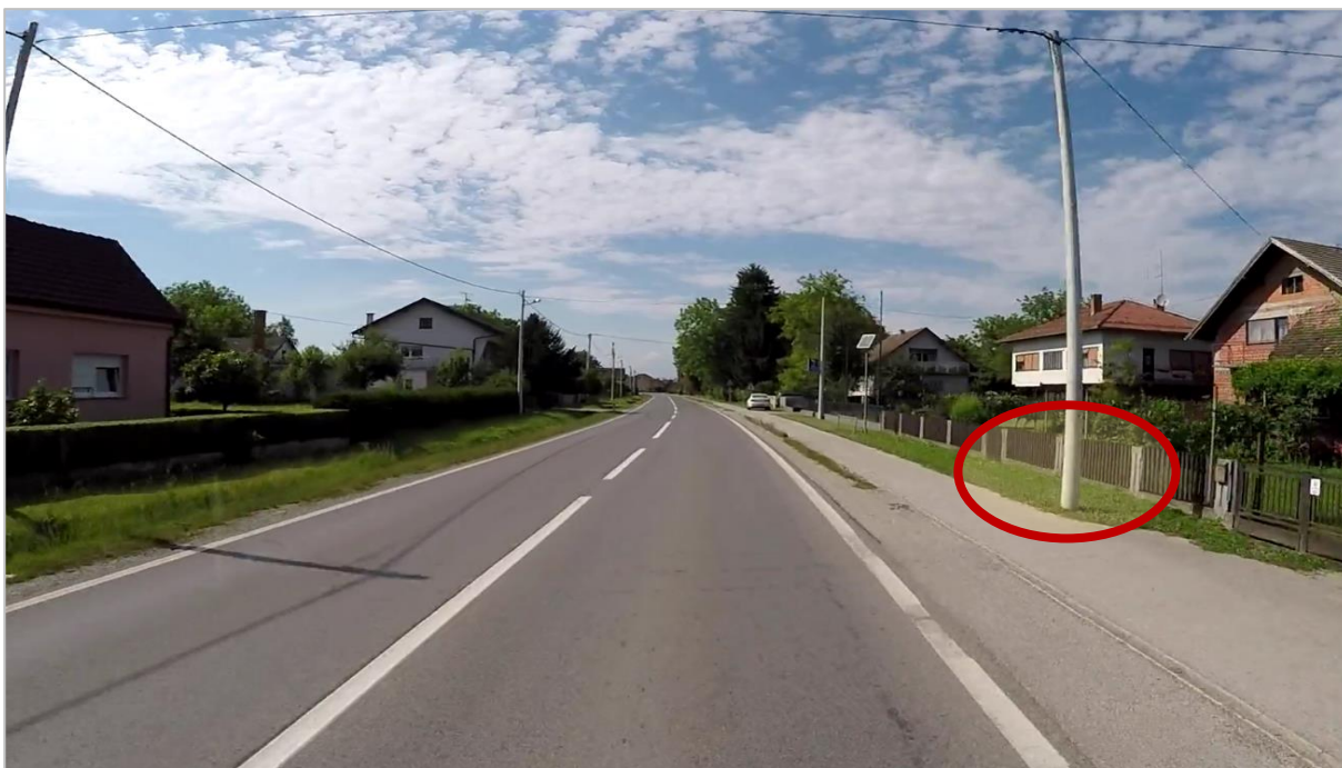
Slika 39. Primjer opasnog mjesta s nezaštićenim metalnim stupom javne rasvjete na desnoj strani ceste (dionica Velika Gorica – Žažina).
