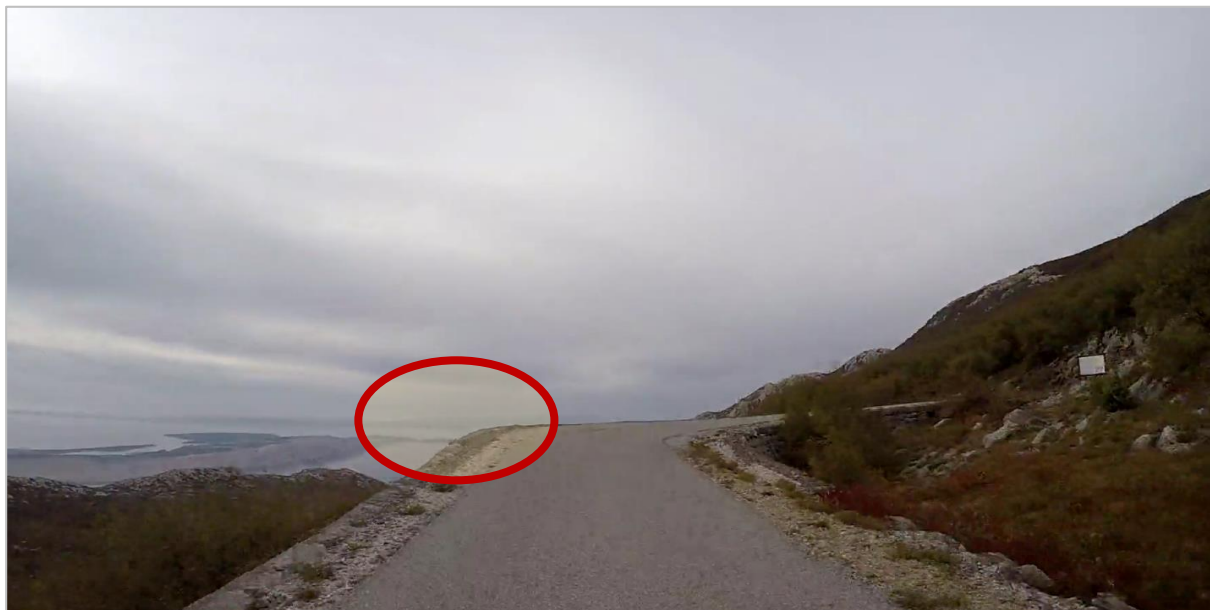
Slika 52. Primjer opasnog mjesta sa provalijom na lijevoj strani ceste, bez postavljene zaštitne odbojne ograde (Stinica (D8) – županijska cesta ŽC5126).
