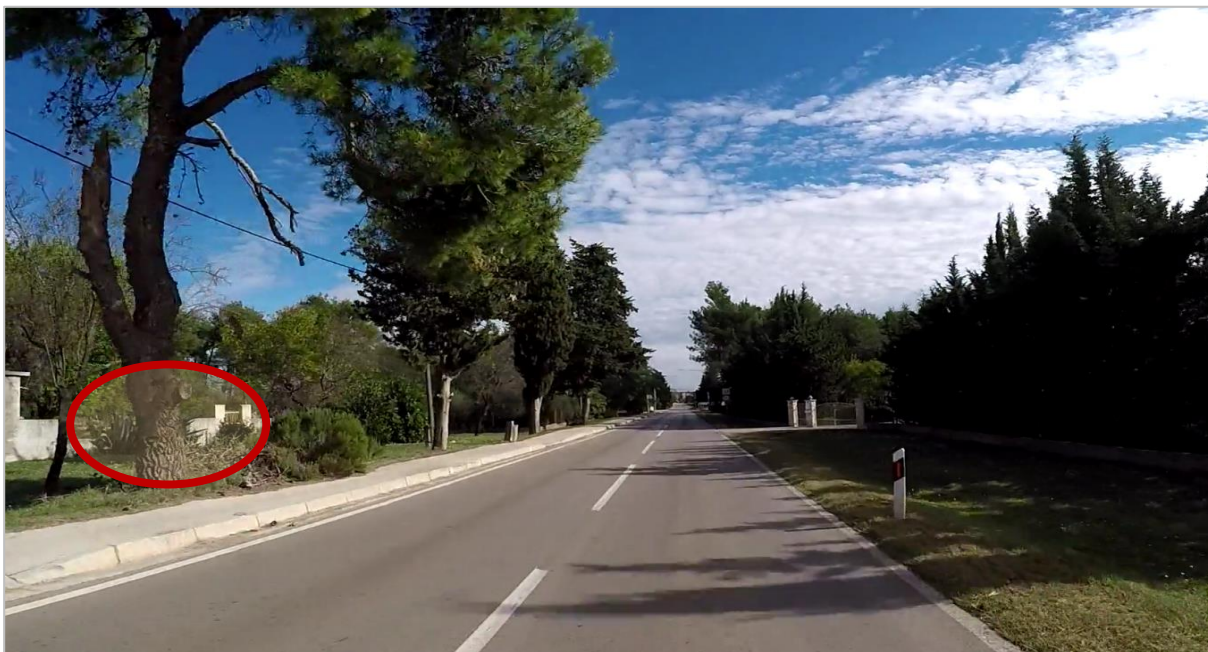
Slika 45. Primjer opasnog mjesta s nezaštićenim stablom većeg promjera na lijevoj strani ceste (dionica Nin – Zemunik Donji).
