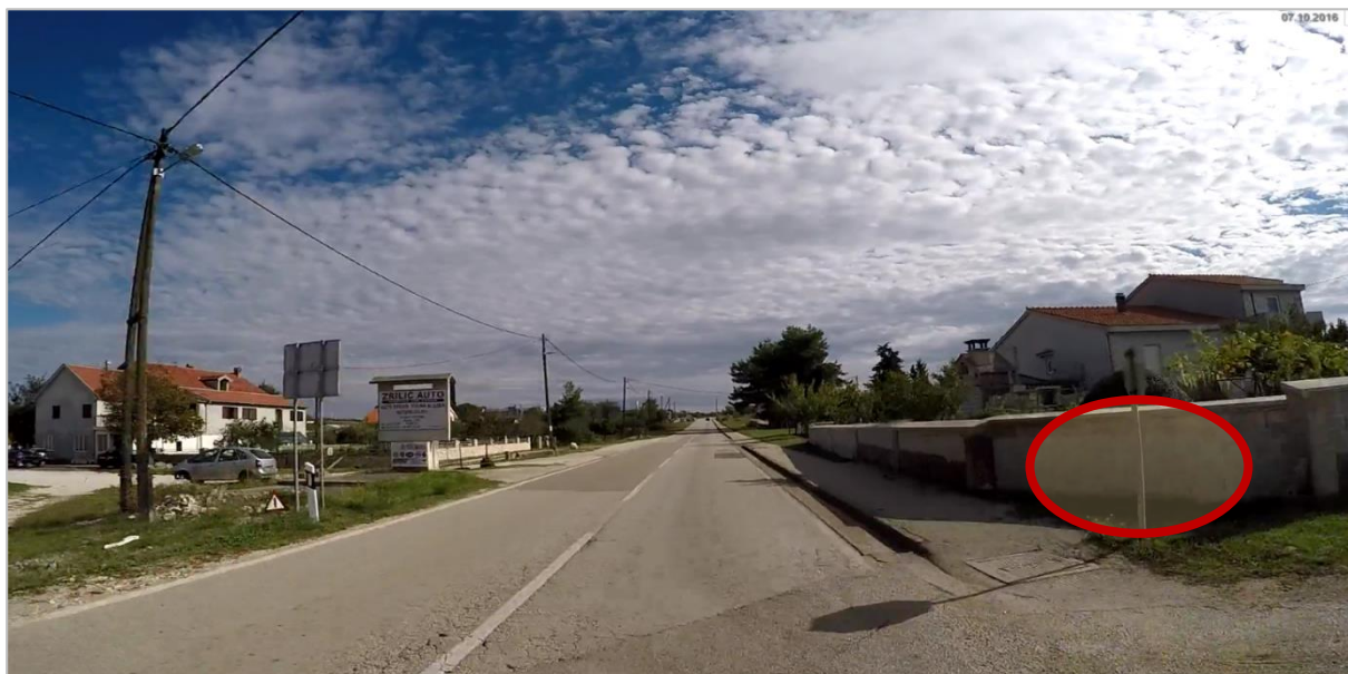
Slika 48. Primjer opasnog mjesta s opasnim čvrstim objektom na desnoj strani ceste (dionica Nin– Zemunik Donji).
